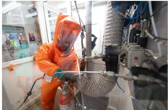
2. Les bouteilles sont déchargées dans un bâtiment dépressurisé (- 50 pascals), elles sont ensuite pesées, étiquetées et placées dans les bâtiments de stockage, en fonction de la spécificité du gaz.
