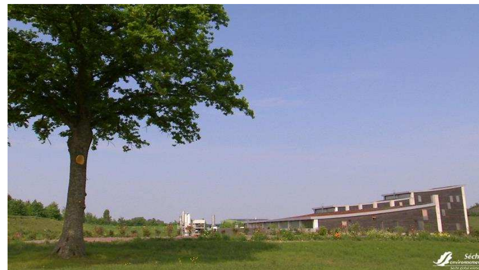
Unité de fabrication du Combustible Solide de Récupération à Changé (Mayenne)
