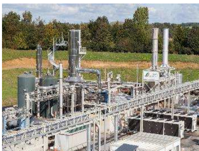
SES : valorisation énergétique de déchets non dangereux
