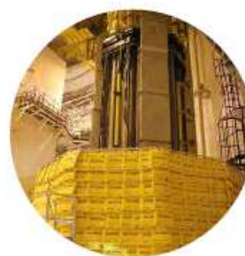
Mise en place de radio-protections (France)
