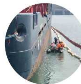
Chantier de dépollution Charente-Maritime (17)
